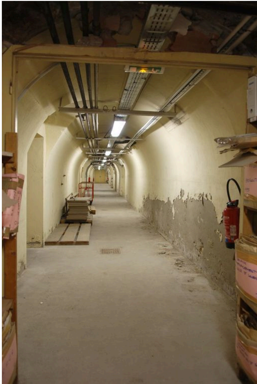
Sous-sol du bâtiment des services généraux, couloir voûté nord-sud
