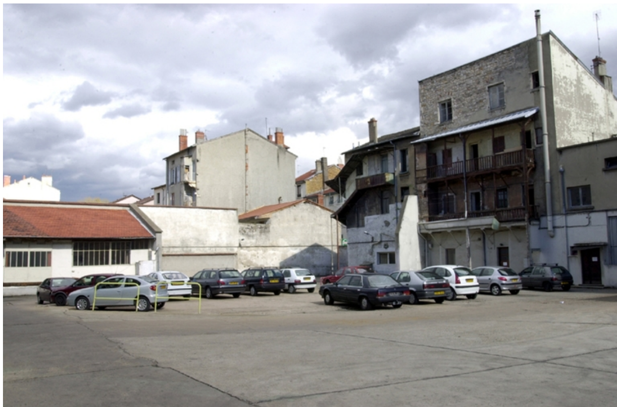
Vue d'ensemble sud
