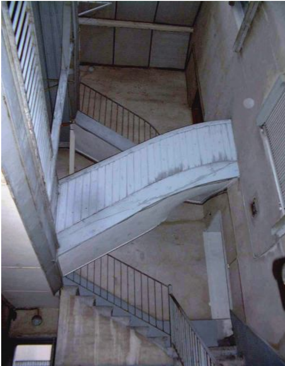
Vue d'ensemble de l'escalier desservant le 2 et le 4 rue Seguin
