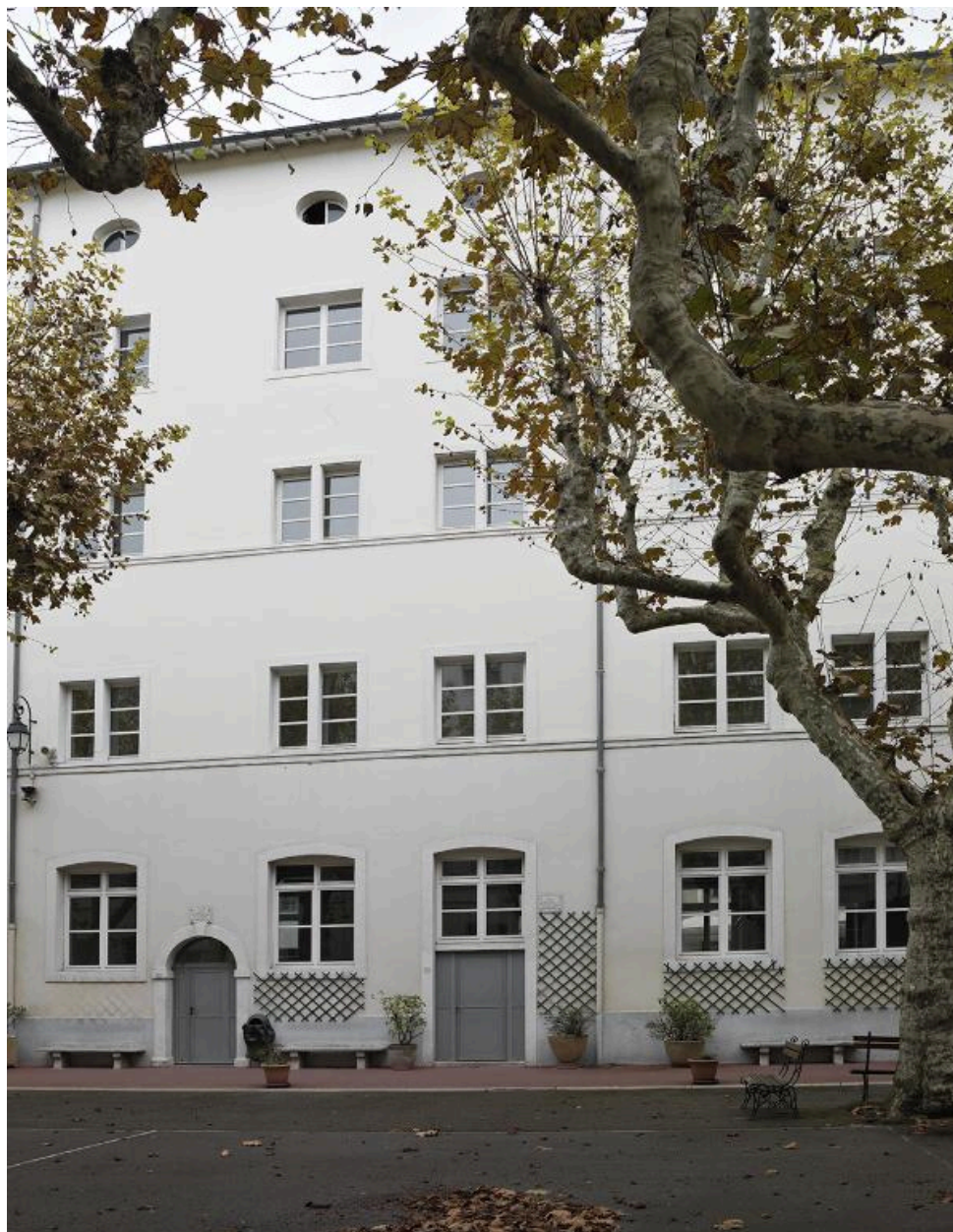
Cour intérieure, élévation est, vue partielle
