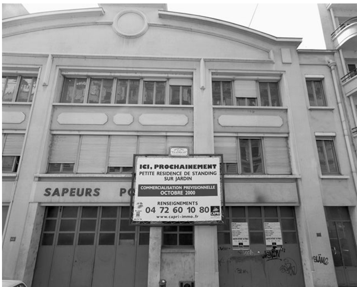
Vue partielle de l'élévation antérieure
