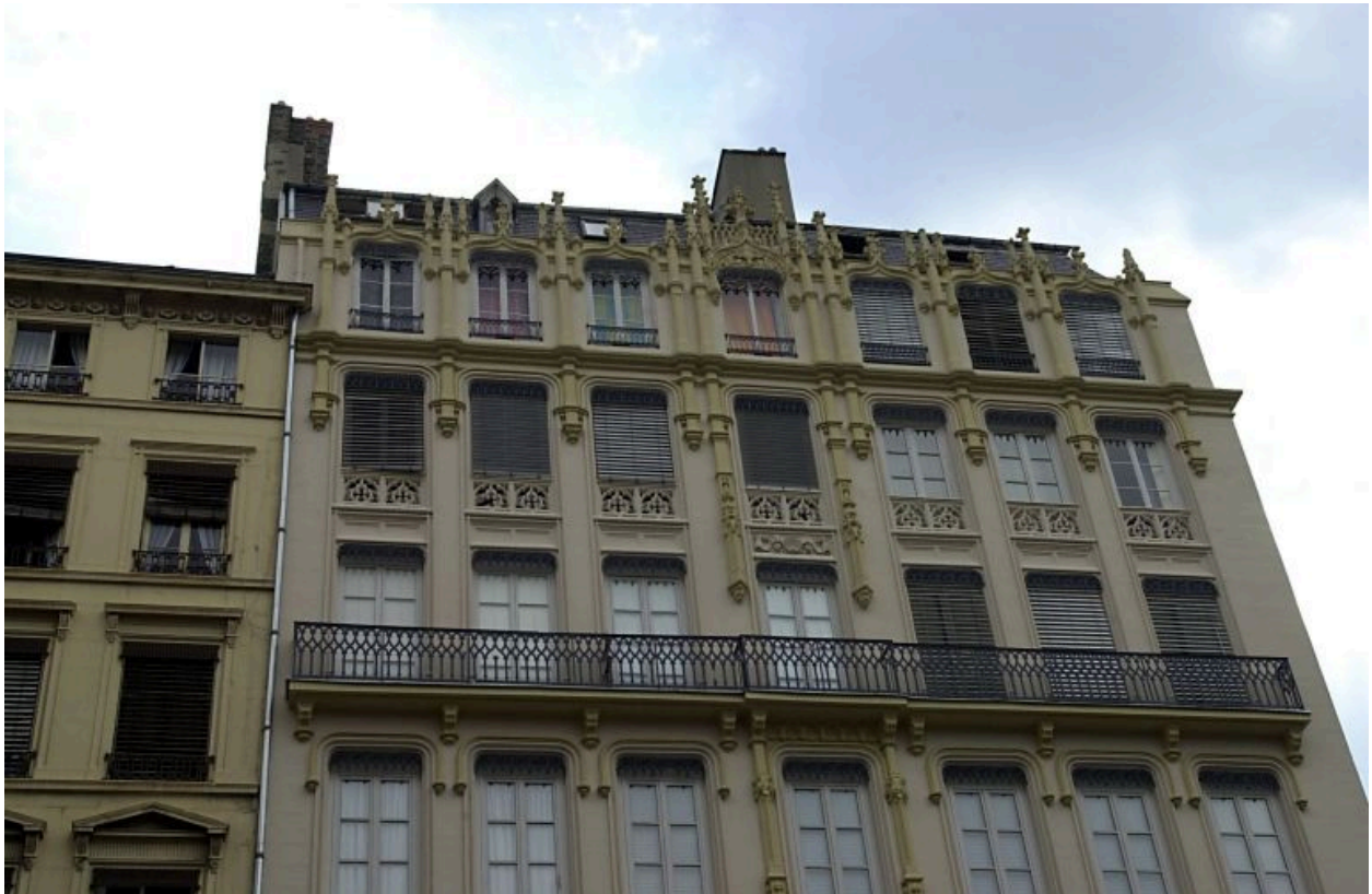
Façade principale rue Chavanne, vue rapprochée des derniers niveaux
