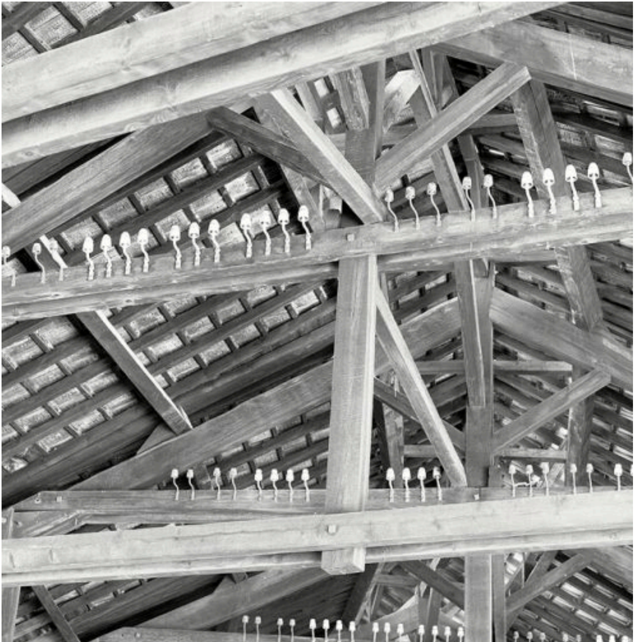
Détail de la charpente
