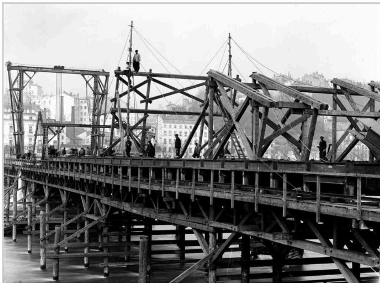
La construction du pont de la Boucle. La construction des arches supérieures. [1903]. 1 photogr. : n. et b. (AM Lyon. 15 Ph 1812)
