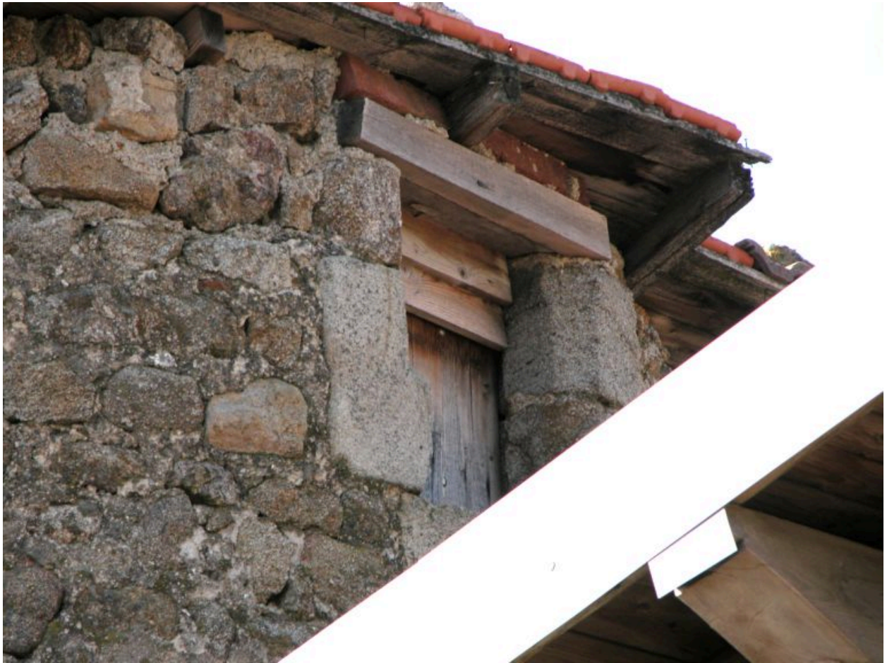
Détail d'une baie haute de l'escalier hors-oeuvre du château.
