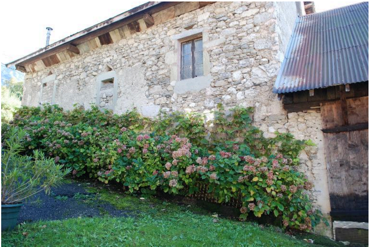
Vue de la façade arrière.
