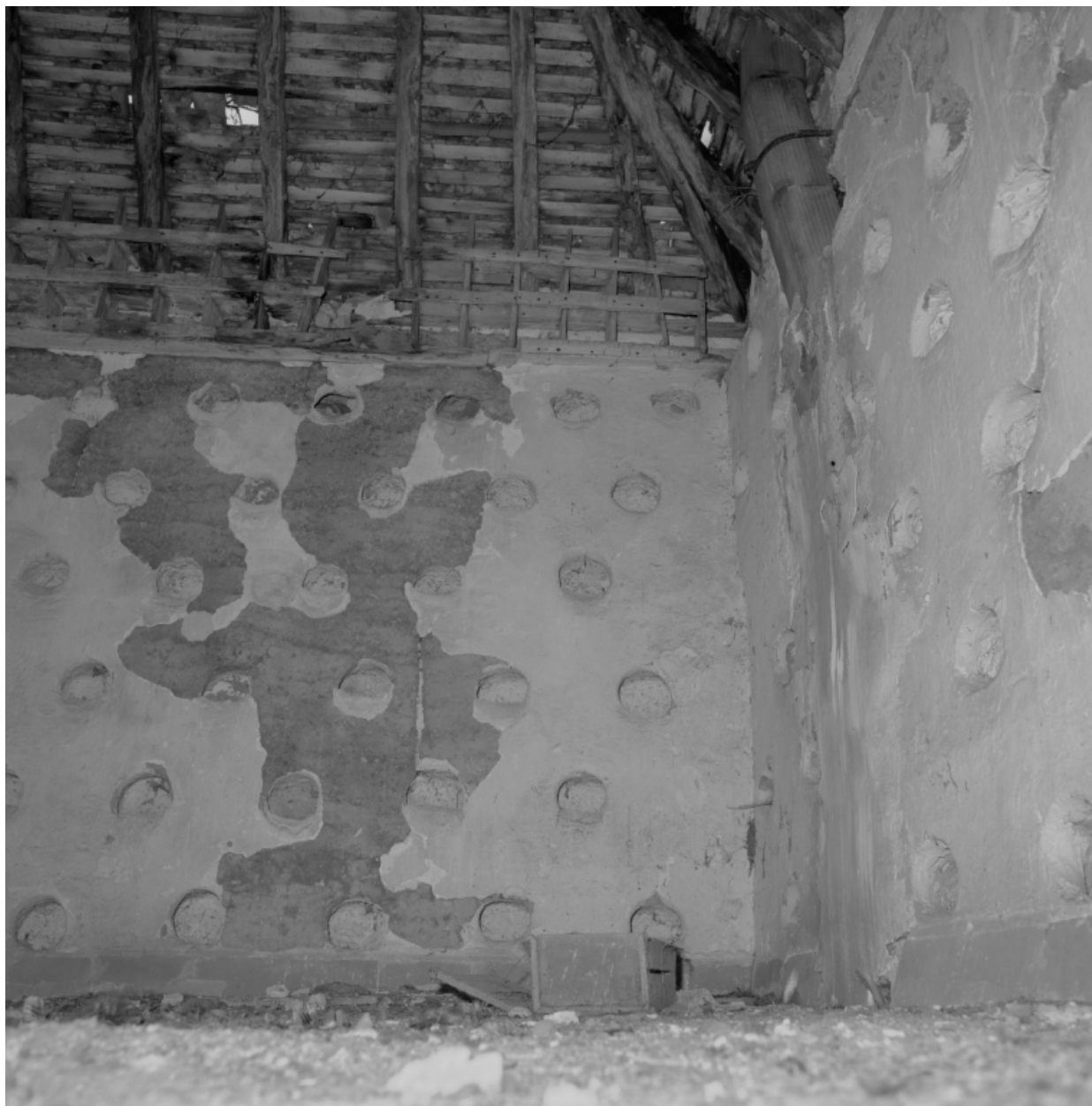
Vue intérieure partielle de la charpente et du mur de surcroît aménagé de boulins.
