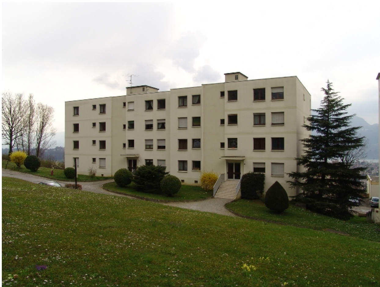
Façade orientale, côté parc
