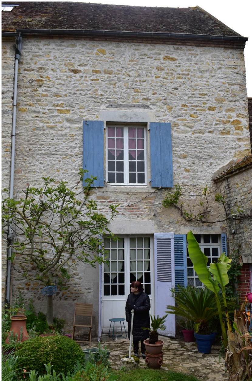
Vue de détail, partie nord, de la façade orientale de la maison.
