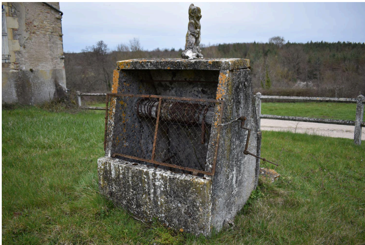
Vue générale du puits
