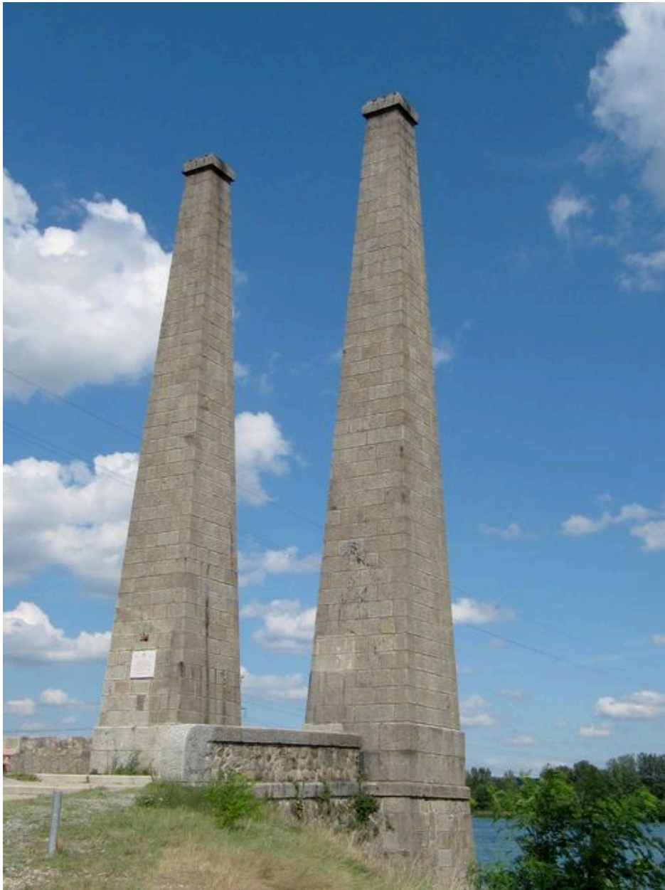
Vue de la pile-culée de la rive droite
