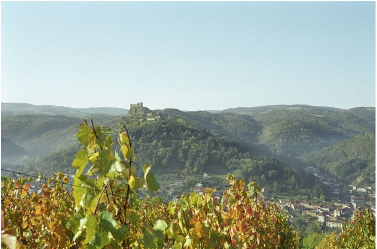
Vue d'ensemble du site de Couzan au sommet du promontoire.
