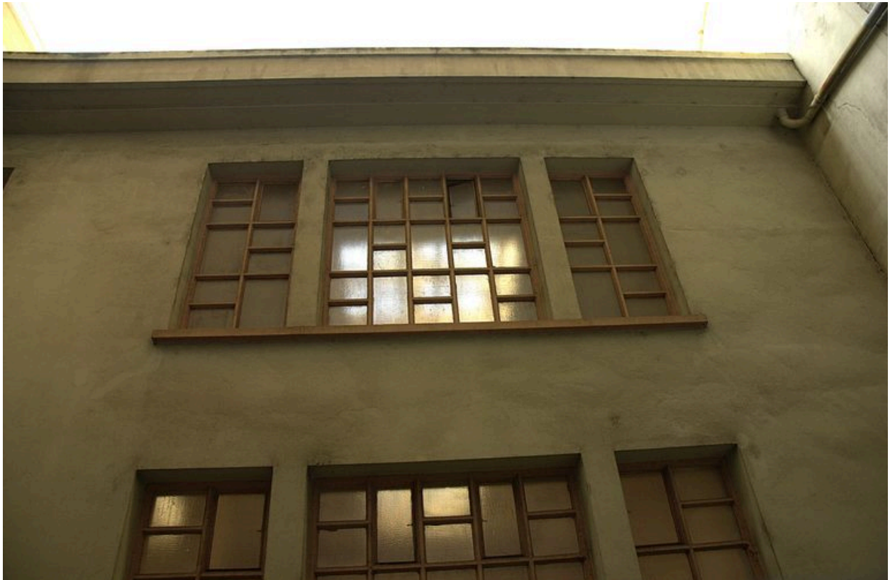
Cour derrière l'immeuble 12 rue du Port du Temple
