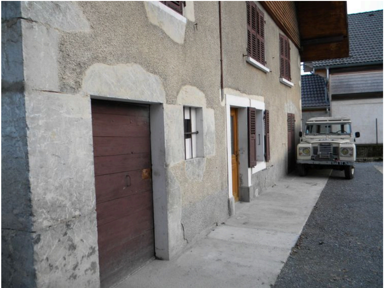
Façade ouest d'une ancienne ferme à juxtaposition (2008 B2 272,273,278 et 2315).
