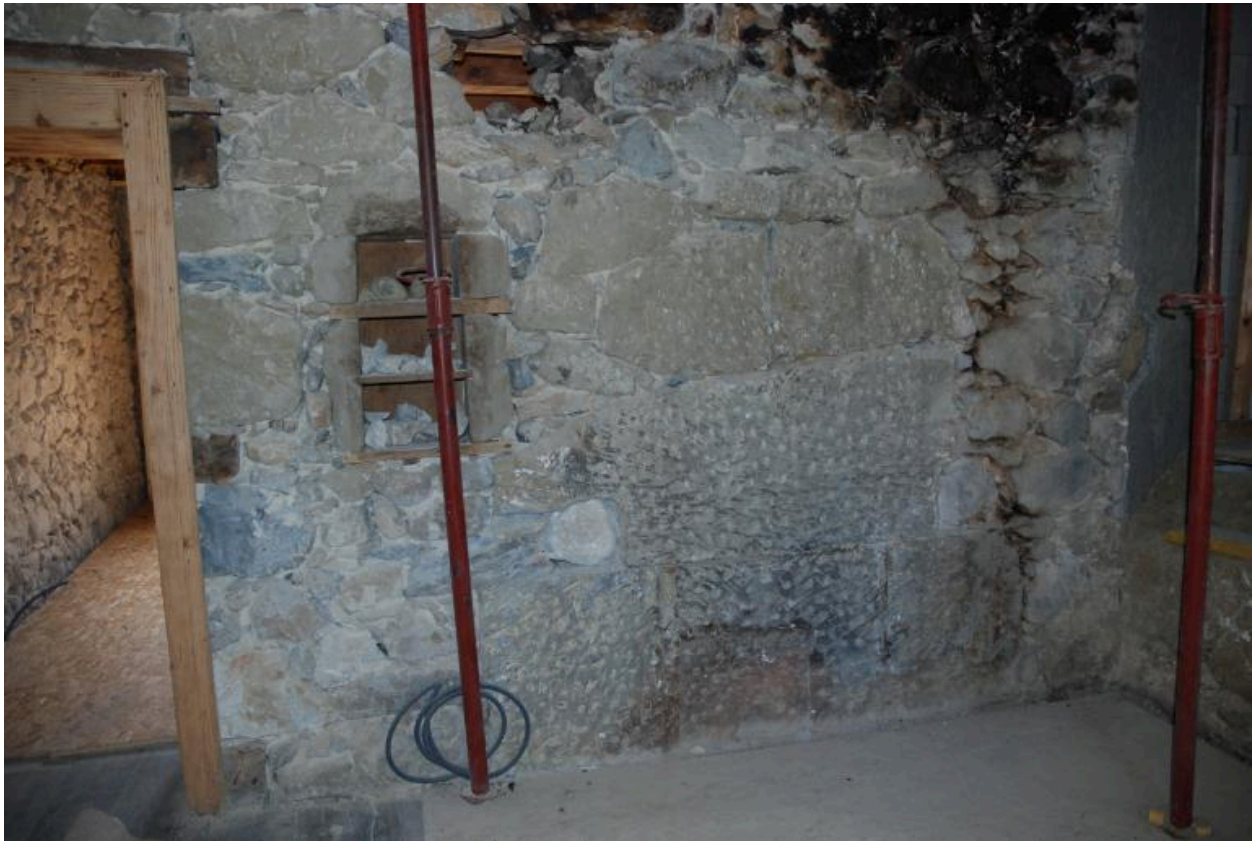
Vue intérieure de la cuisine : contrecœur de la cheminée.
