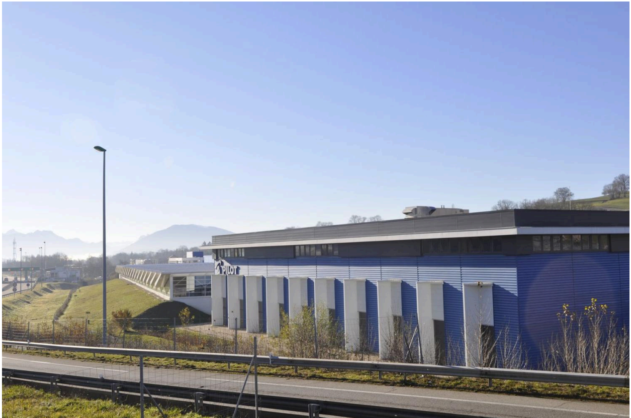
Détail du bâtiment administratif
