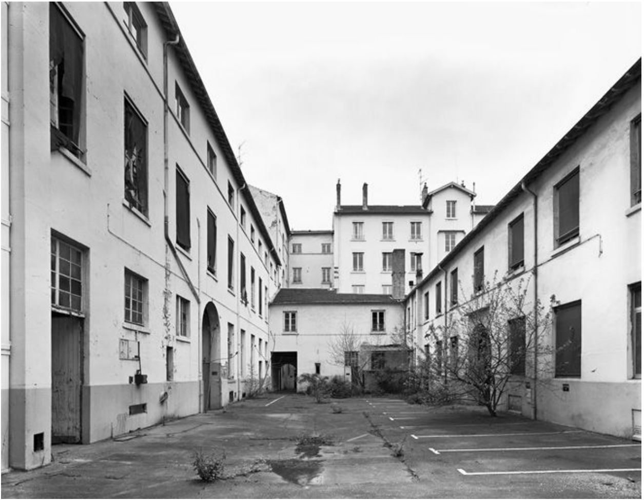
Cour 005, vue générale vers le sud
