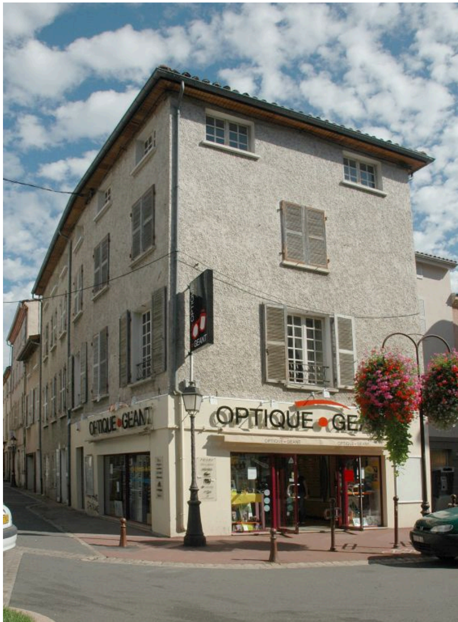
Vue de trois-quarts depuis la rue Tupinerie.
