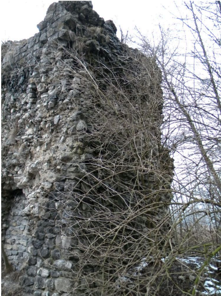
Vue générale des maçonneries.
