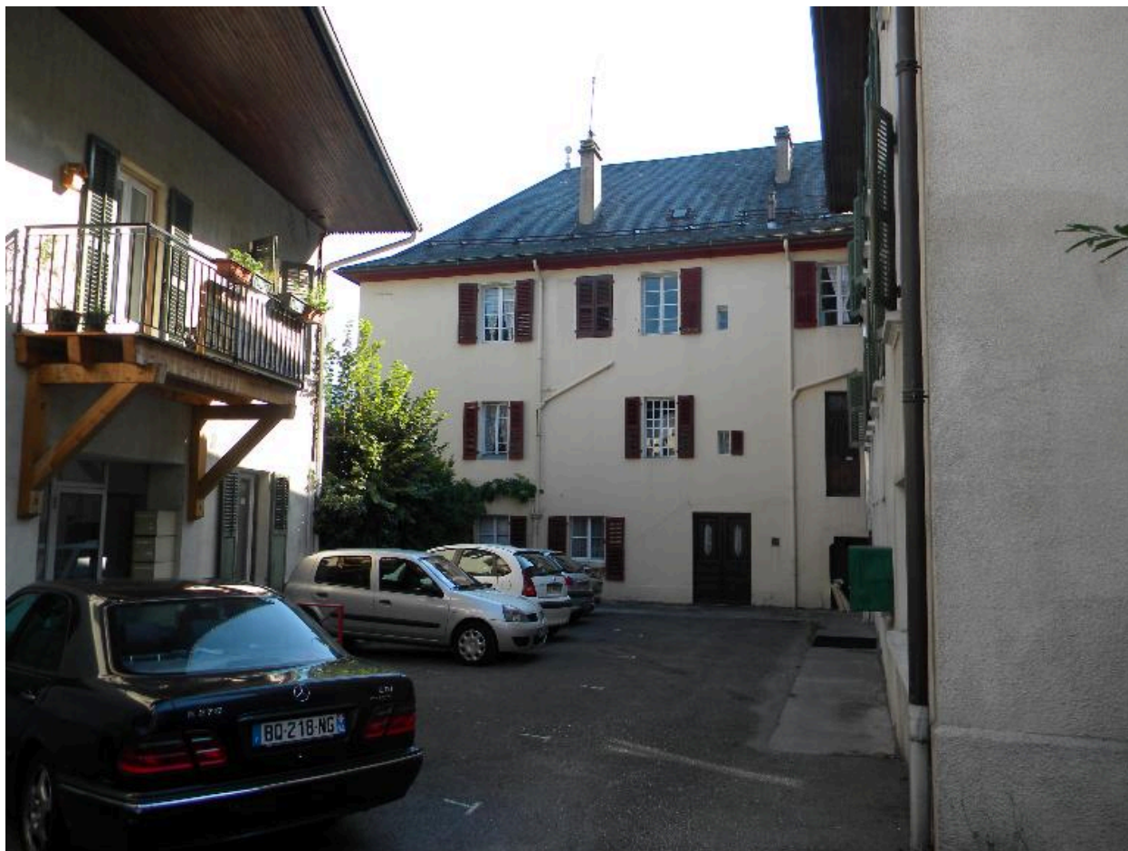
Vue de la façade arrière.
