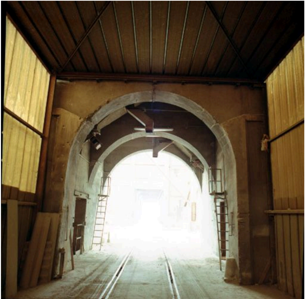
Détail de la porte du silo
