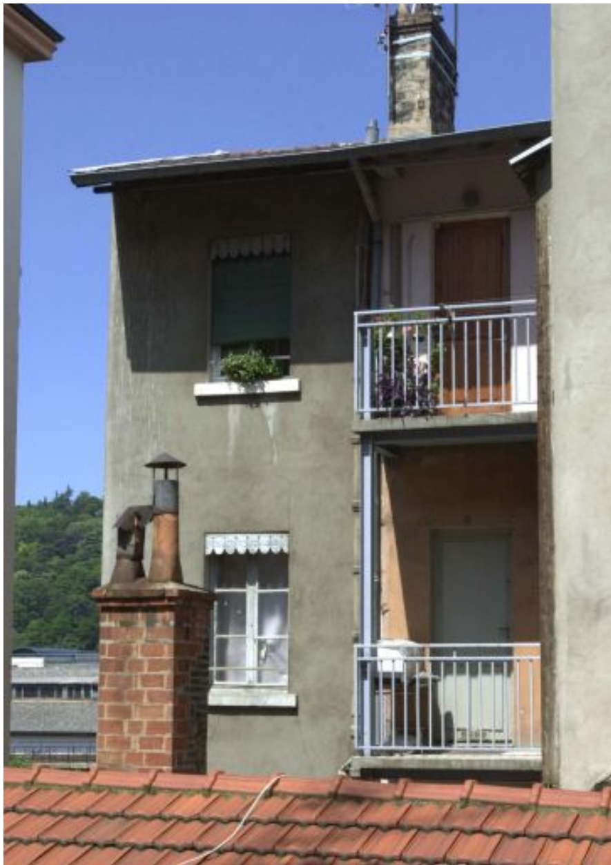
Elévation postérieure de l'immeuble sur rue
