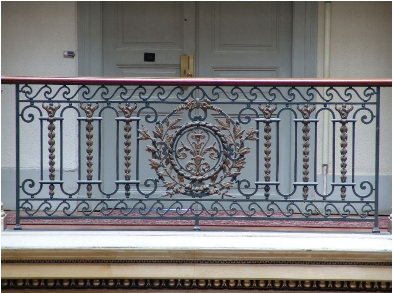
Garde-corps d'une galerie
