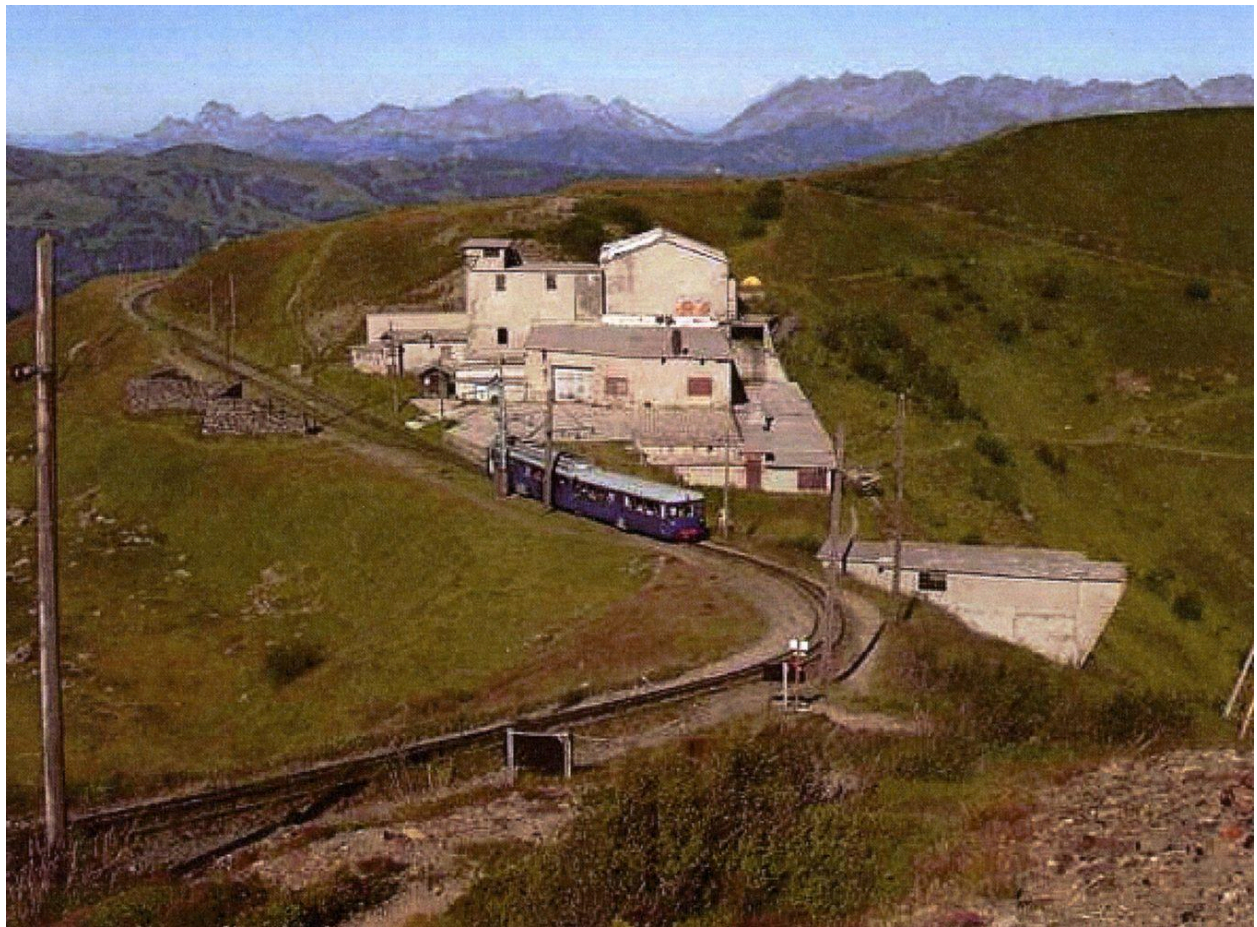
Vue d'ensemble de la soufflerie avant démolition (Centres d'Essais et de Recherches Aéronautiques dans le Sud-Est)
