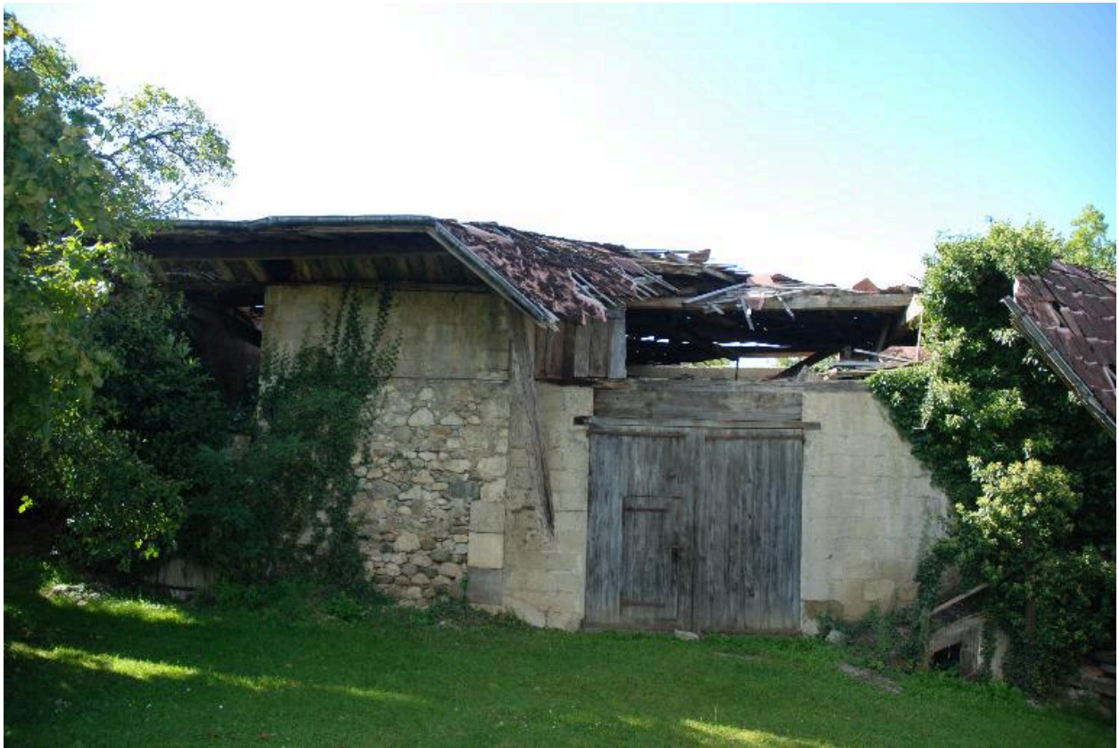
Vue d'ensemble : grange, étable et remise.
