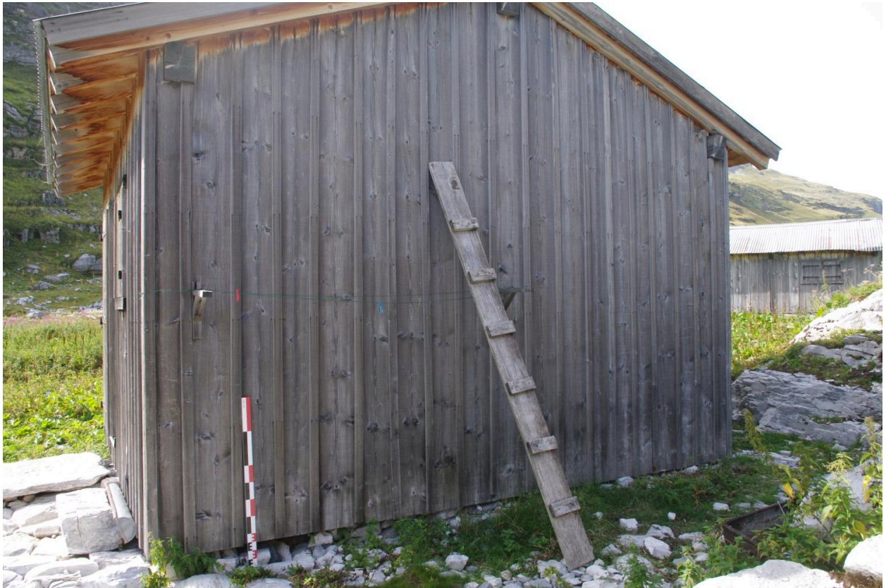
Vue du mur pignon est
