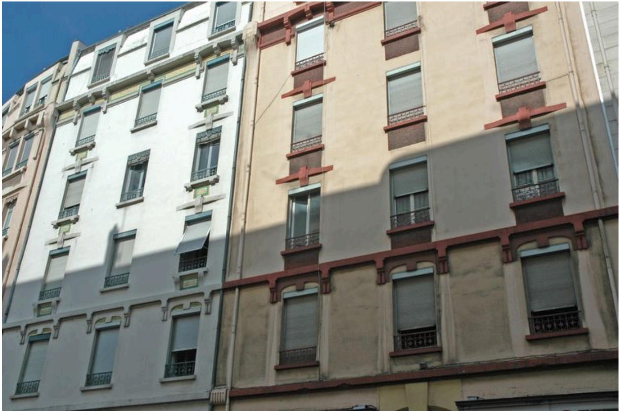
270-272 rue de Créqui. Détail de l'élévation principale
