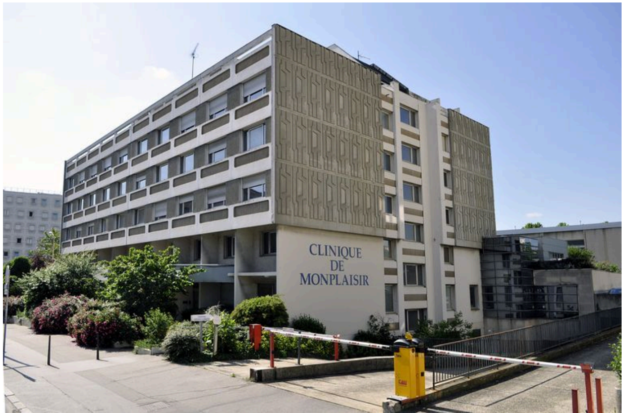
Façade antérieure nord et façade latérale ouest
