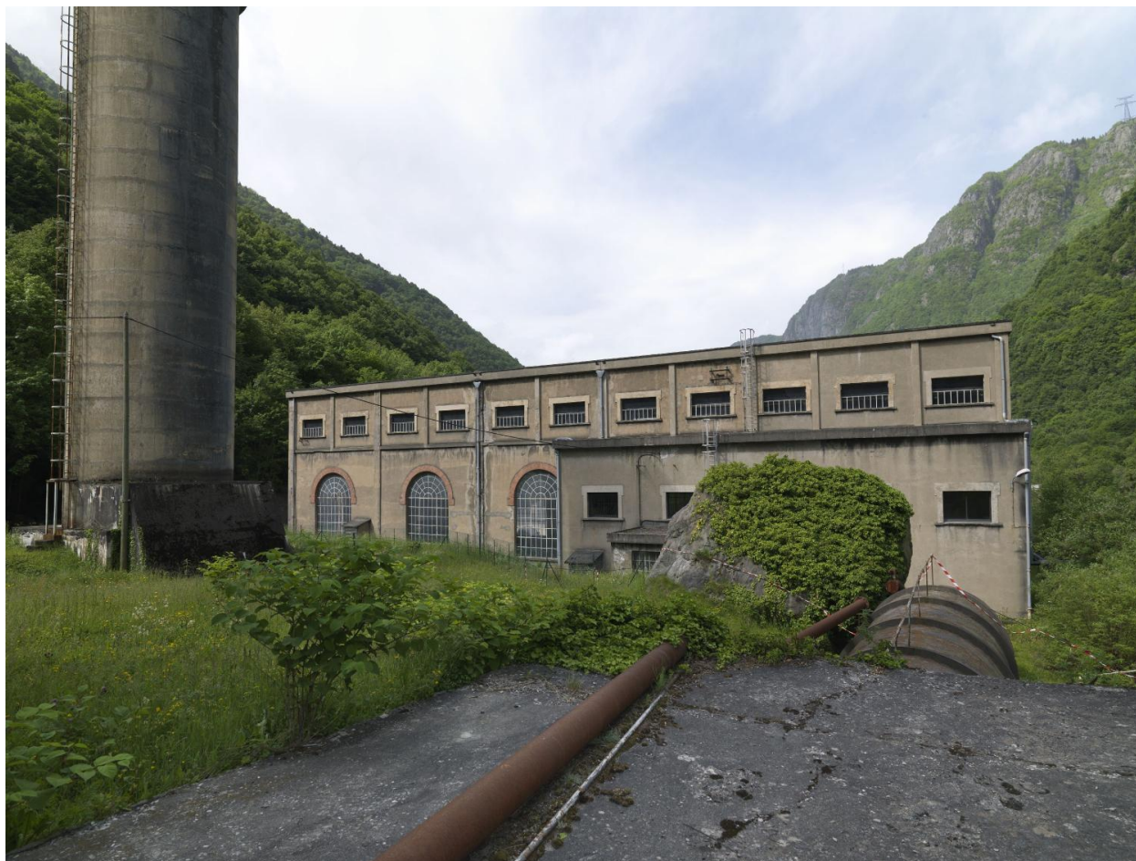
Vue arrière de la centrale
