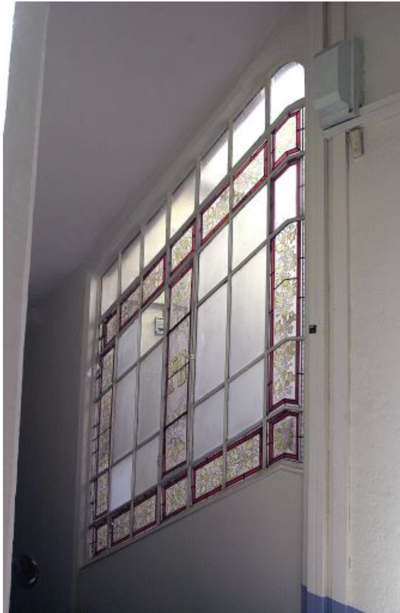
Escalier, détail d'une verrière
