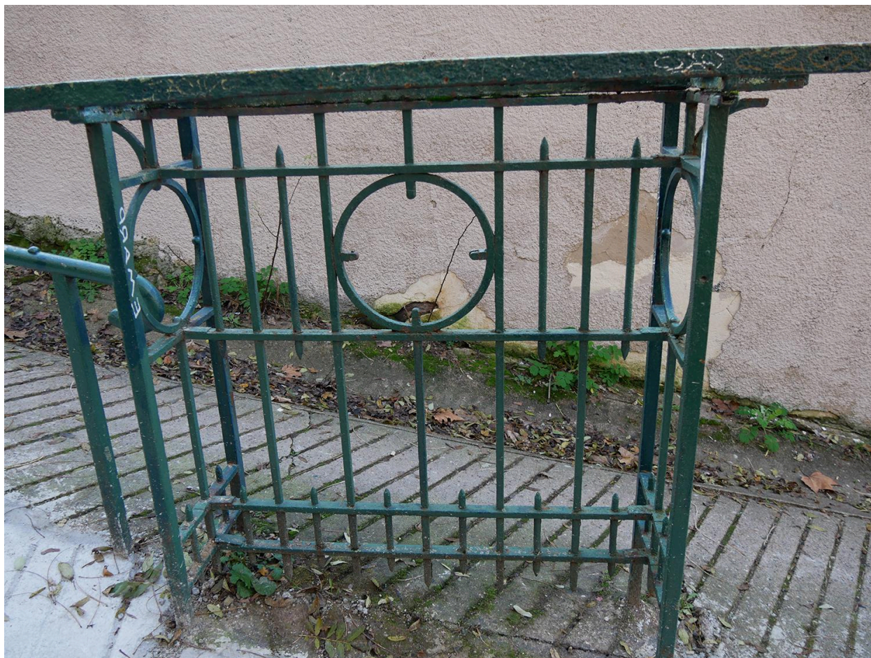
Détail Console Vignal ou reposoir localisée rue de la Carrière Lyon 5e
