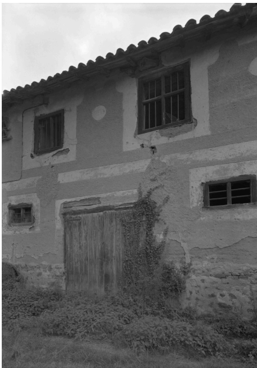
Premier ensemble. Bâtiment sud-est : façade du cuvage et du logis.
