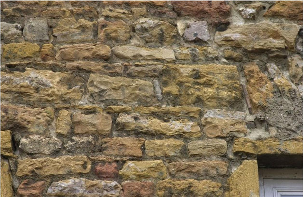
Détails de l'appareil en moellon du mur sur rue
