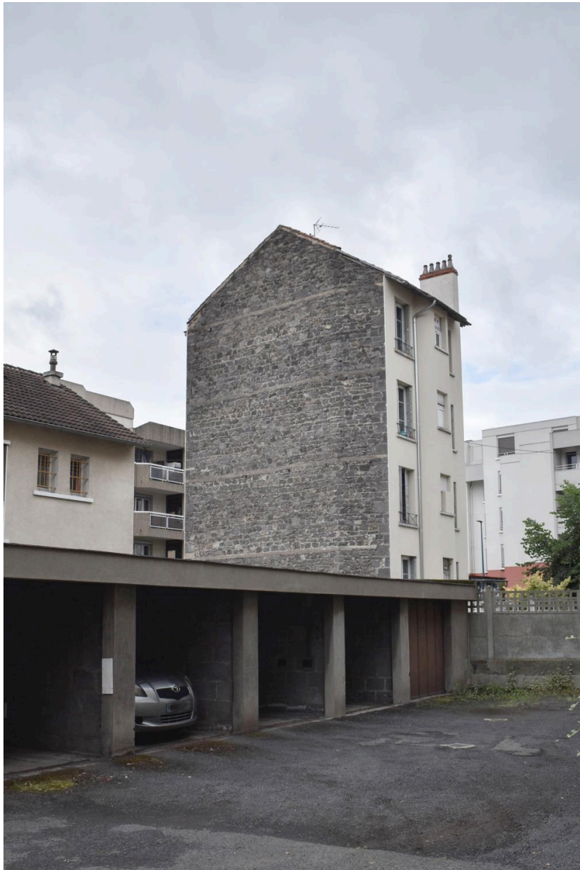
Elévation aveugle latérale et façade postérieure, vue depuis la cour du coeur d'îlot
