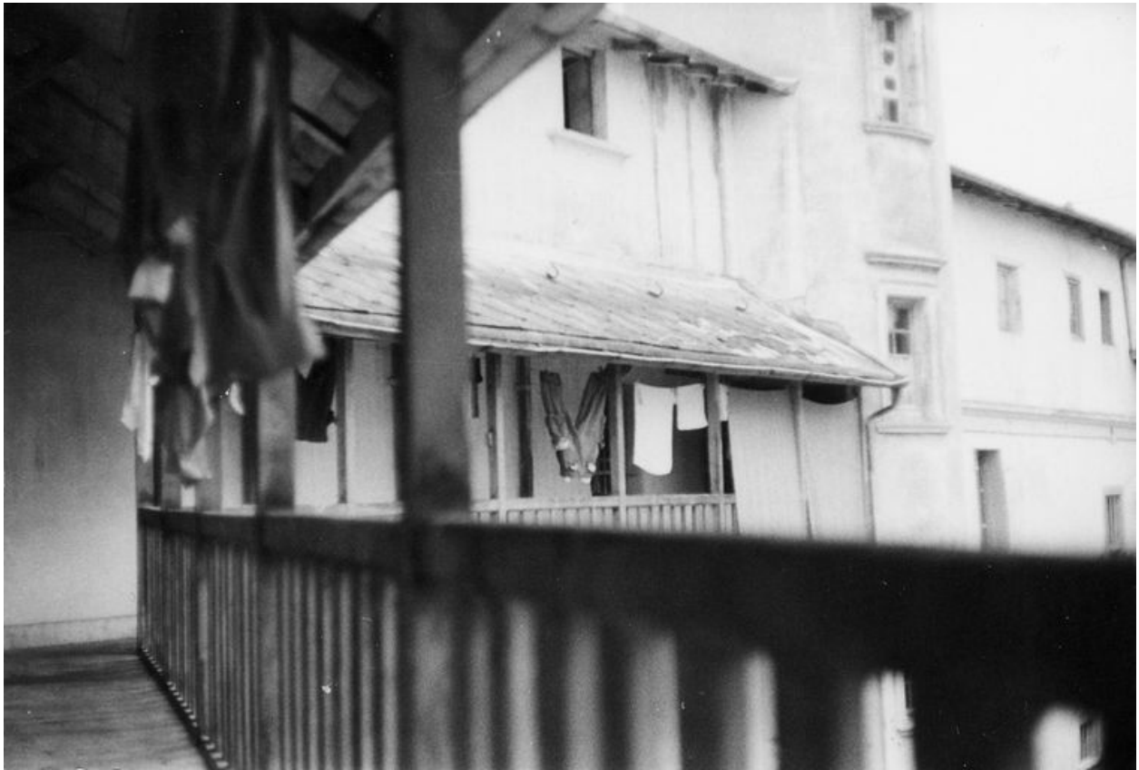
Elévation sur cour. La coursière depuis l'est. Vue prise en 1970
