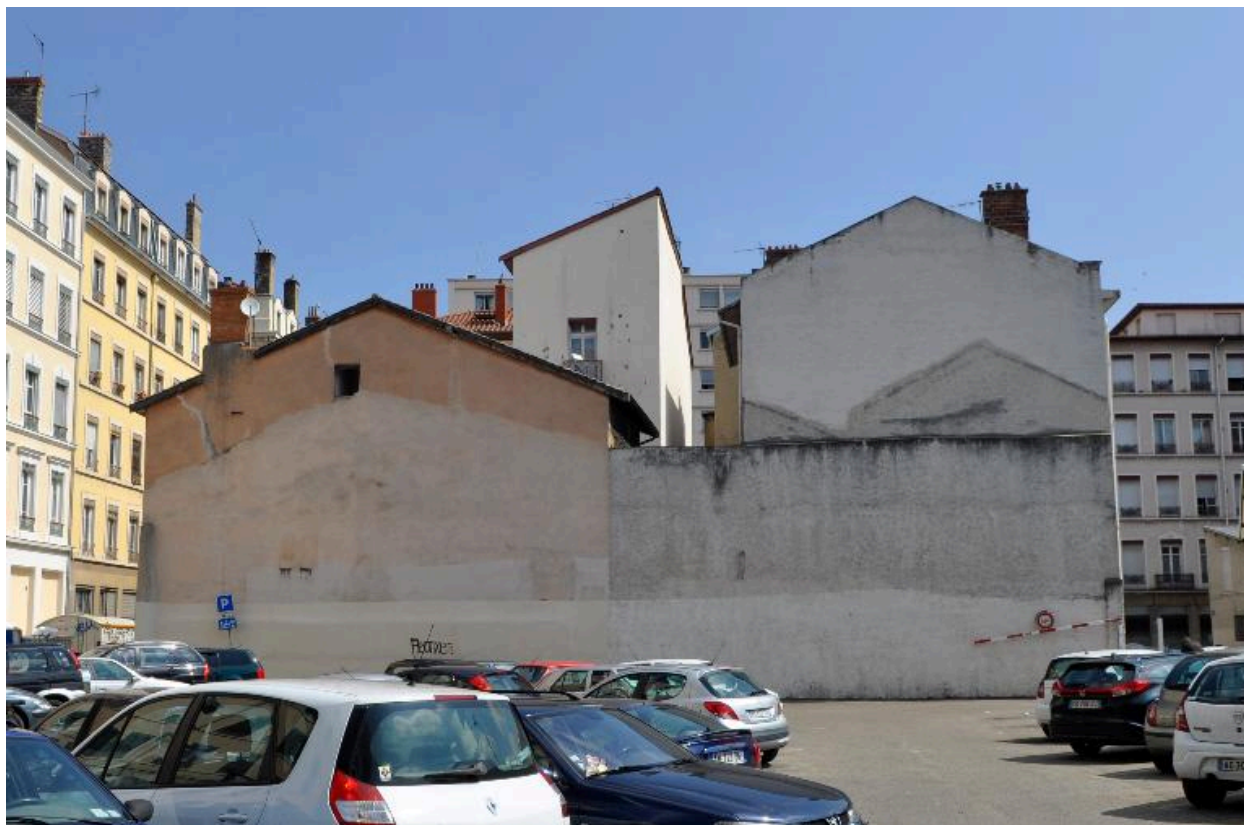
Vue de situation au sein de l'ilot et mur pignon sud, entièrement aveugle
