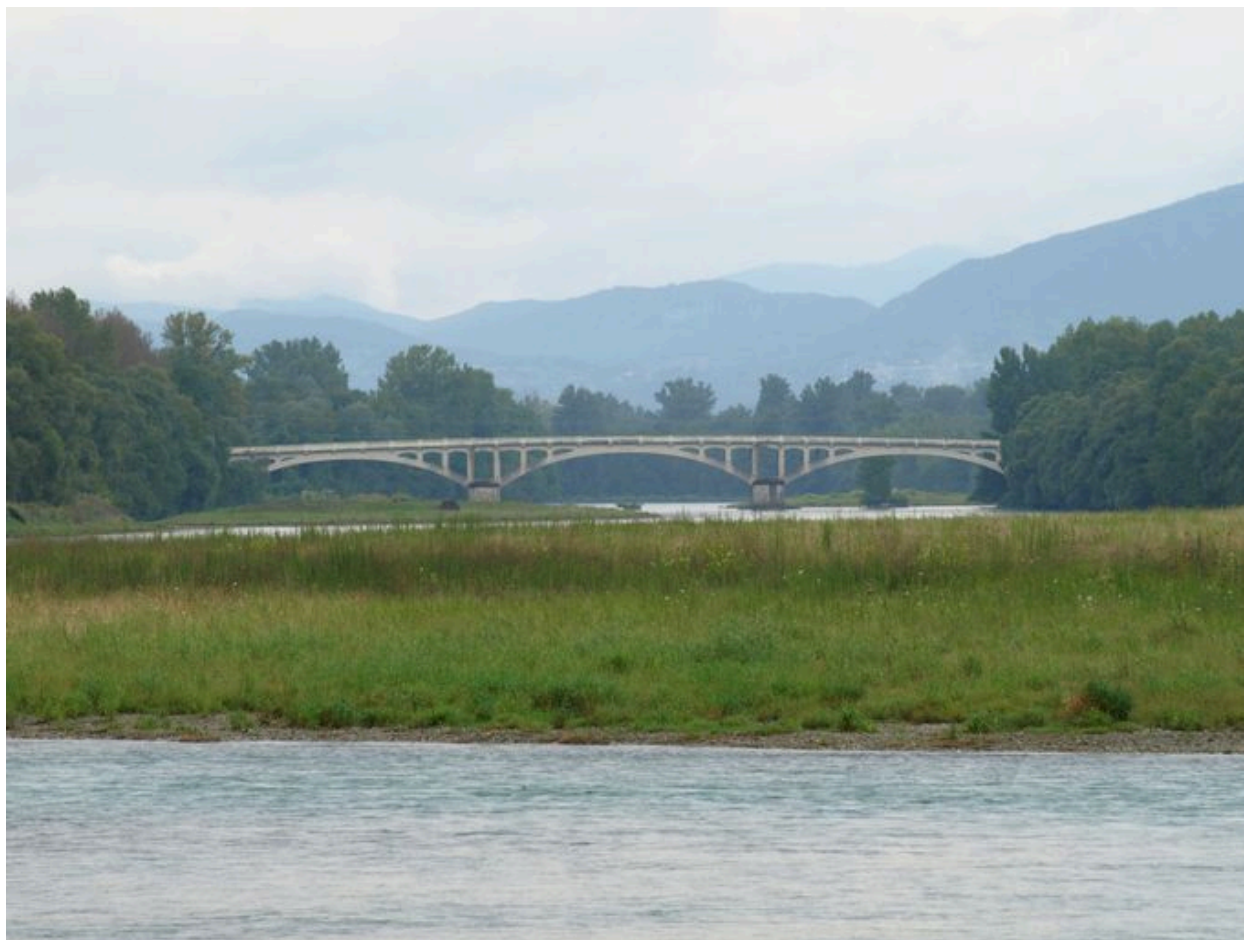
Vue générale, face amont
