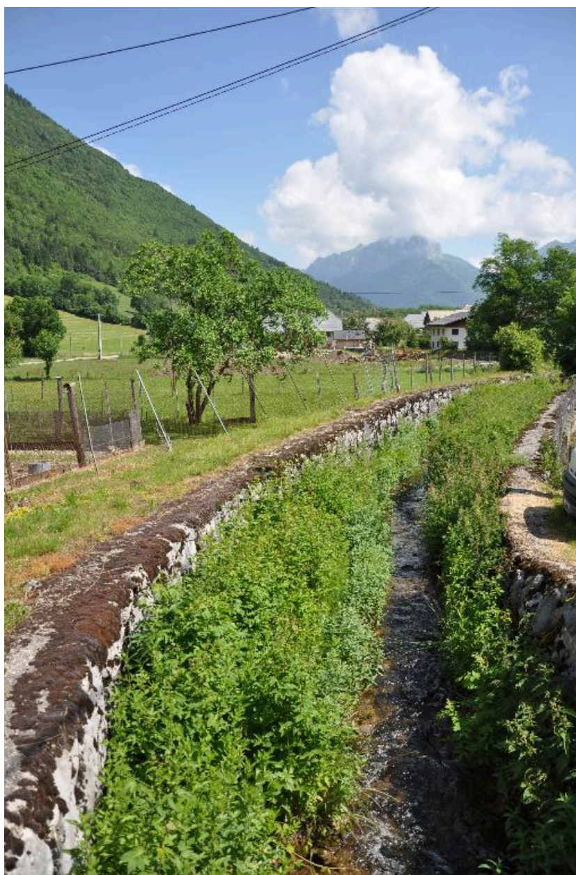
Vue du ruisseau des moulins.
