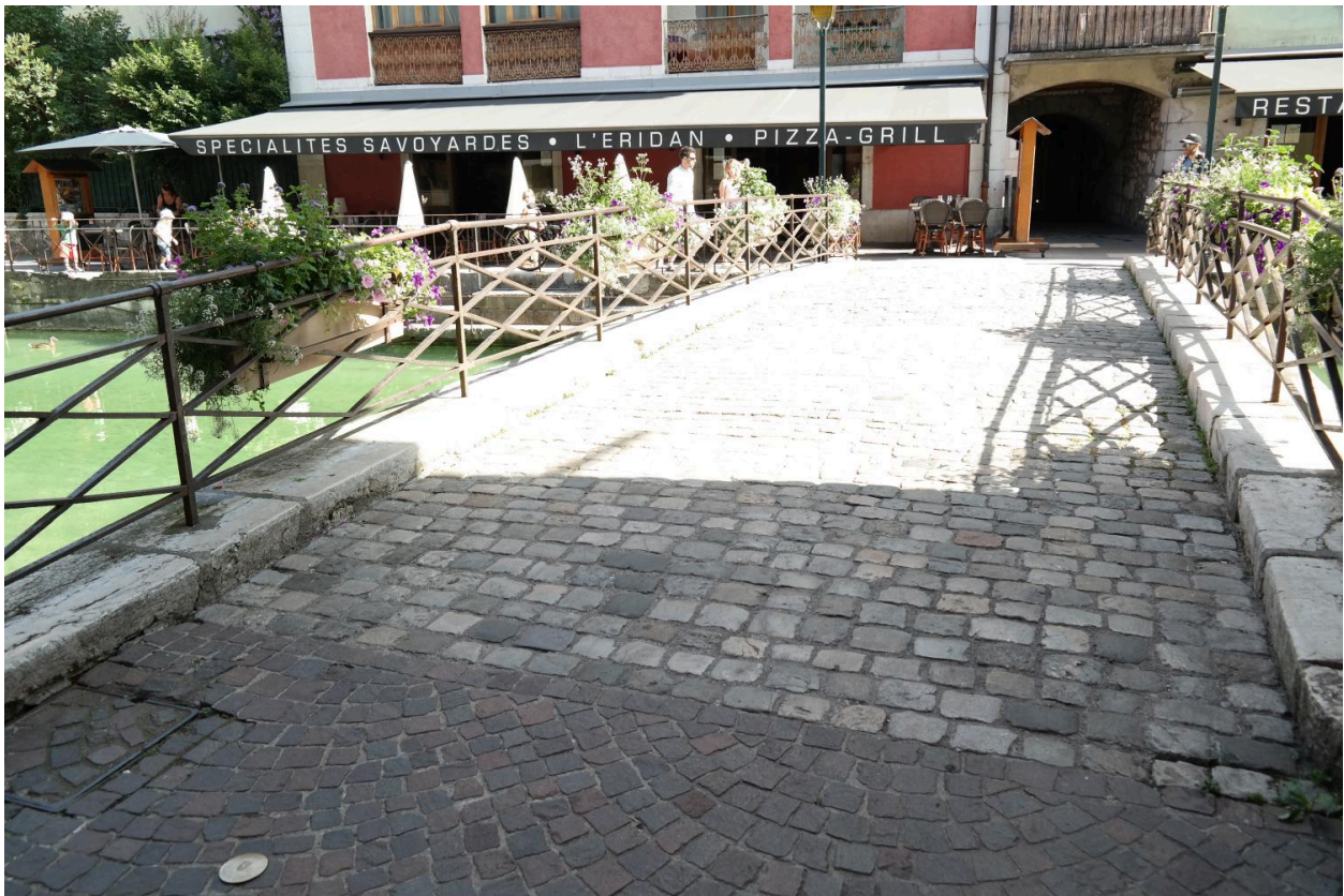
Pont du passage de l'Évêché, vue de la chaussée
