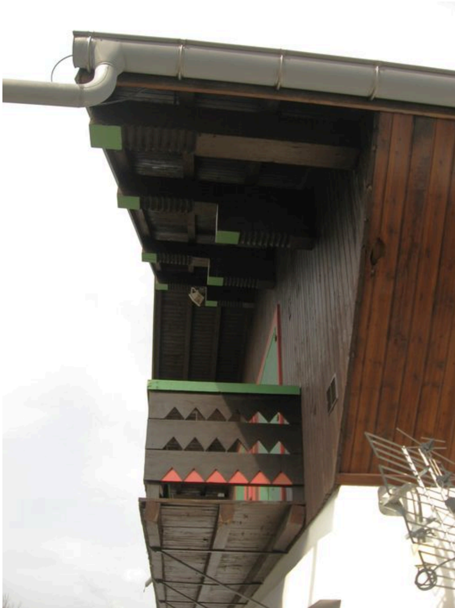
Détail du balcon et de l'avant-toit
