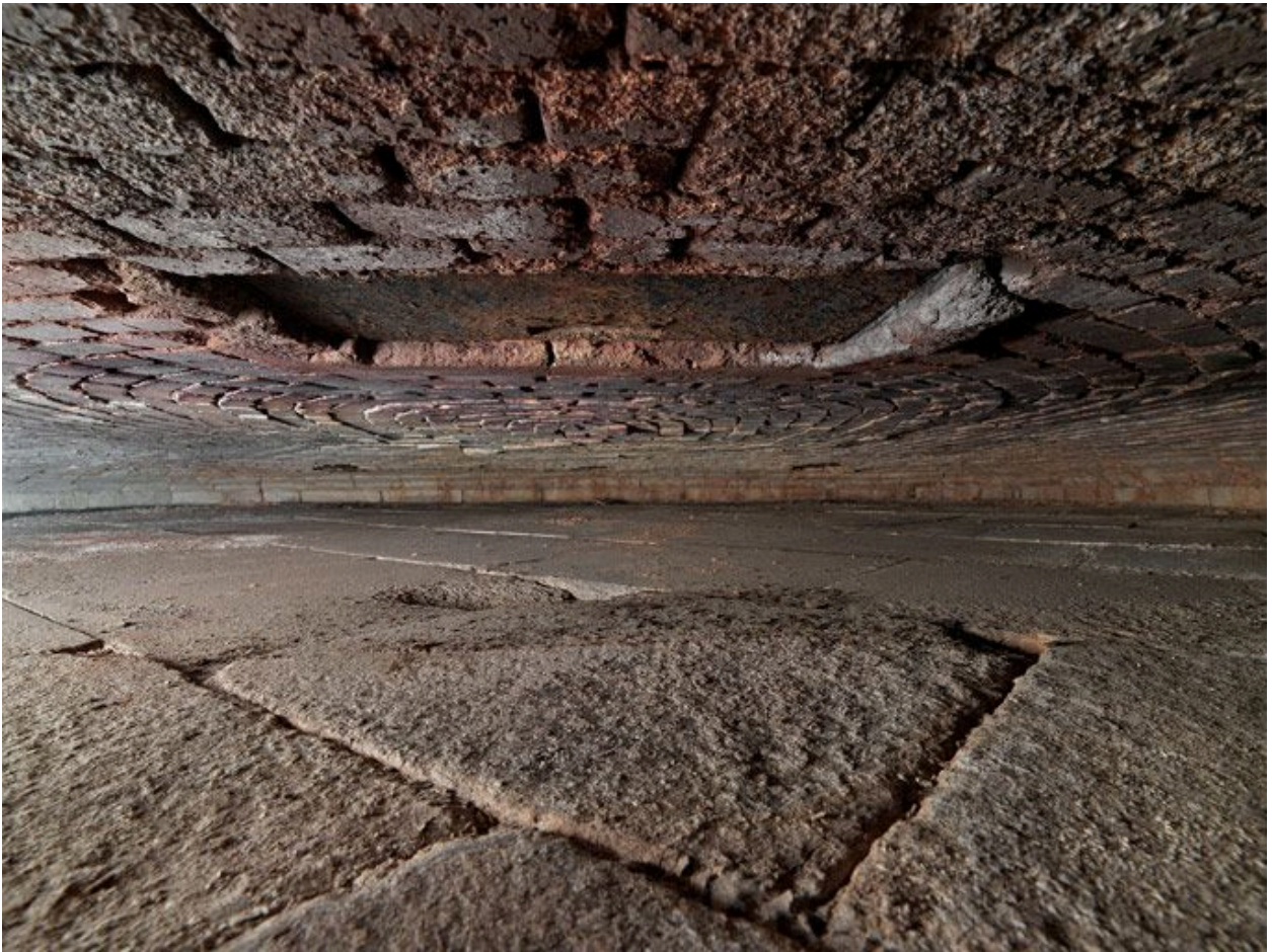
Intérieur d'un four, briques
