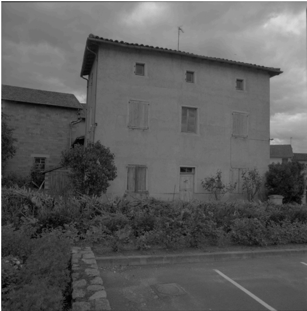
Vue d'ensemble du presbytère.
