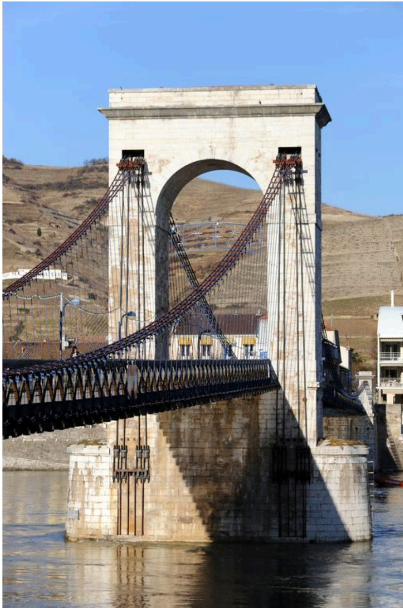
Pile centrale, face aval, vue générale (depuis la rive droite)
