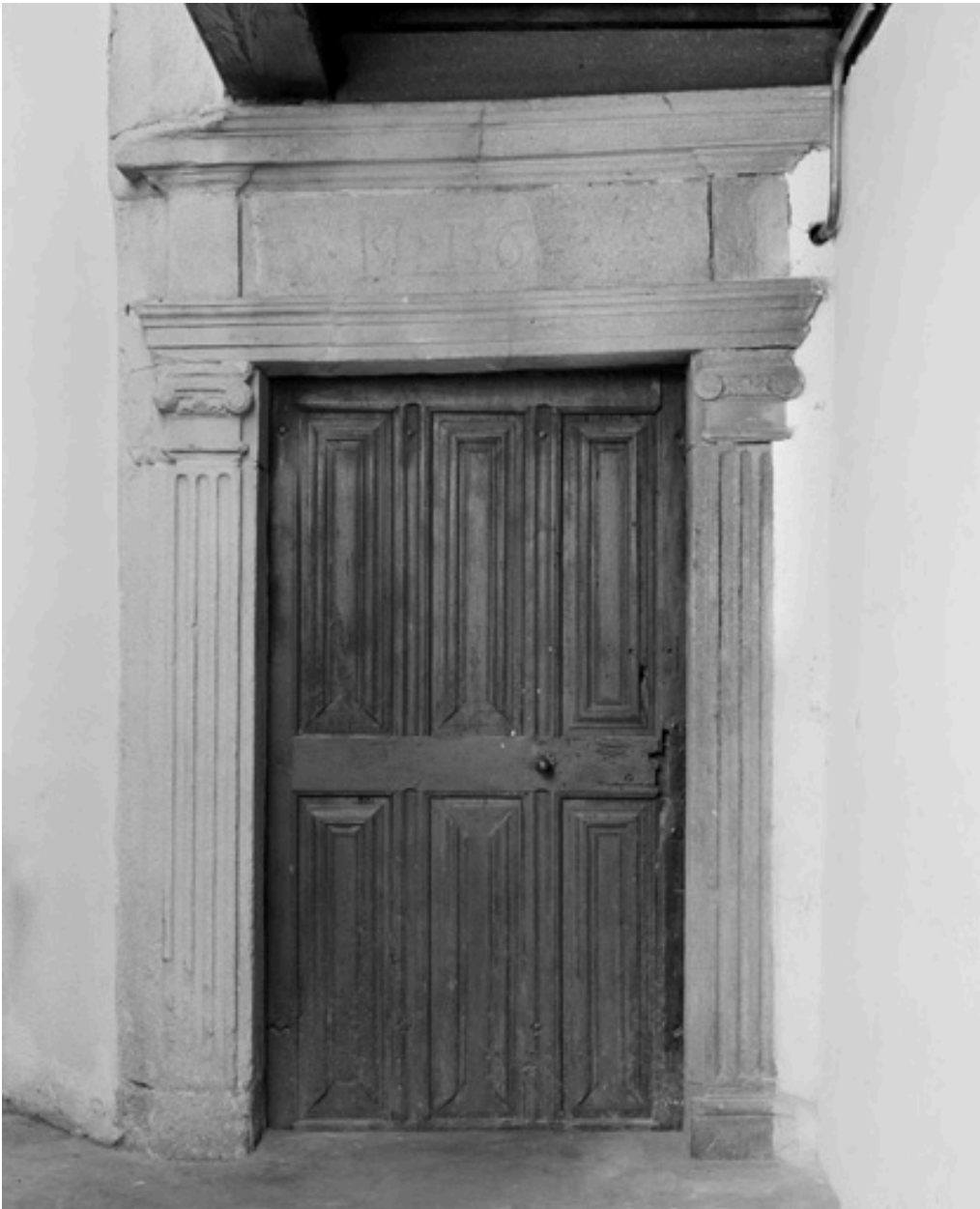
Porte d'accès à l'escalier en vis, datée 1564.
