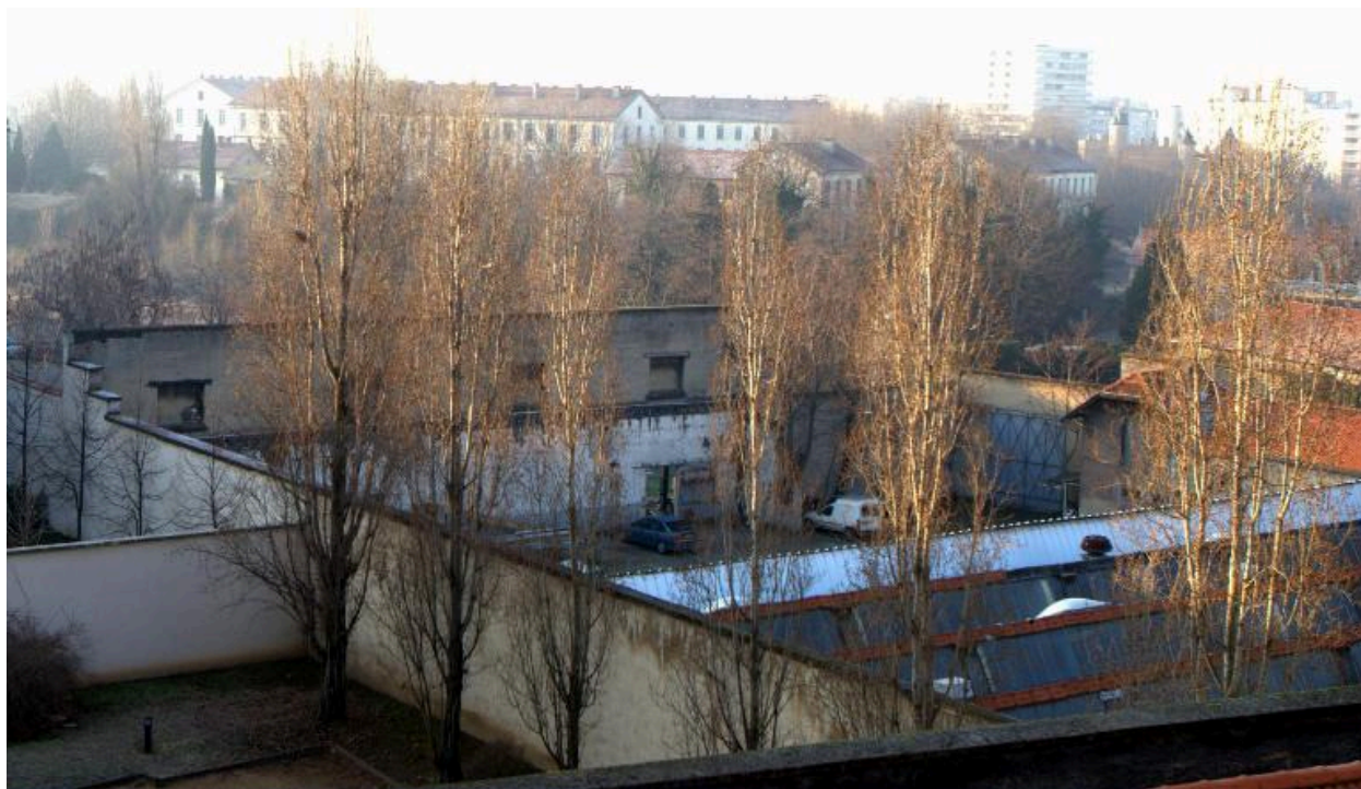
Vue d'ensemble des cours, depuis le nord
