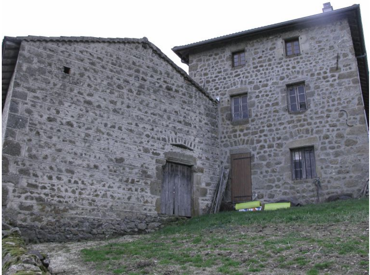
Vue d'ensemble extérieure, de trois-quarts nord-est, de la ferme (1986 H 120).
